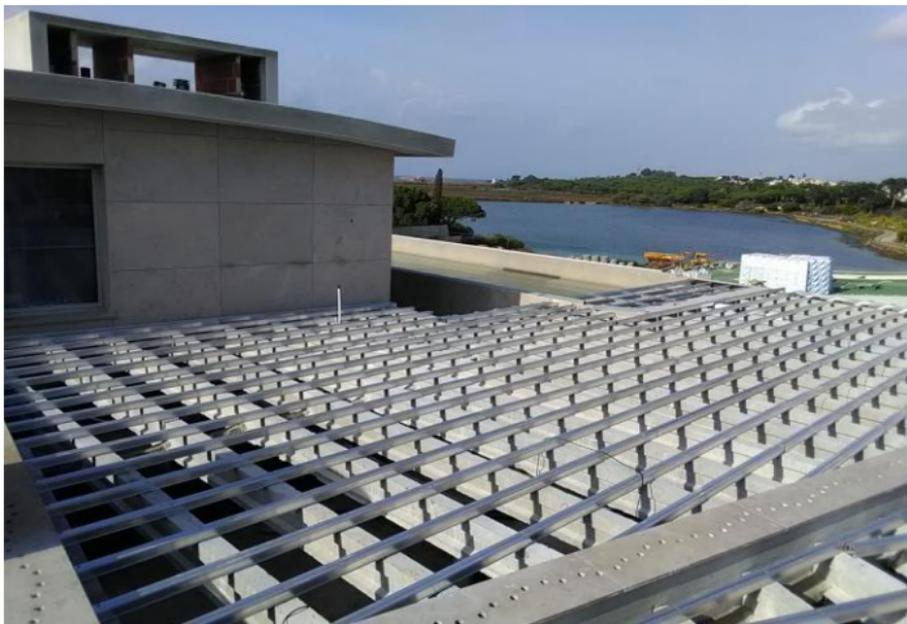
Preparar uma subestrutura pode-nos fazer desesperar... é tão ou mais importante que a instalação de um deck ou de uma revestimento de fachada.
